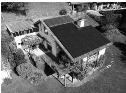
EFH Grossestein, Bachenbülach. Solarthermie 2007 (kleine Fläche im Firstbereich), Photovoltaik 2014 (grosse Fläche).
