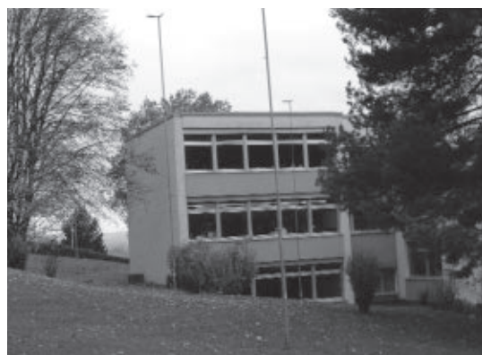
Neubau des Doppelkindergartens
